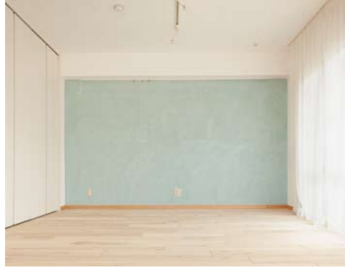
リビングは、左手に見えるクロゼットの奥行きを少し浅くすることでさらに幅を広げ、より開放的に。壁は漆喰。正面のみ明るい水色の漆喰で仕上げ、広い空間のアクセントとした
