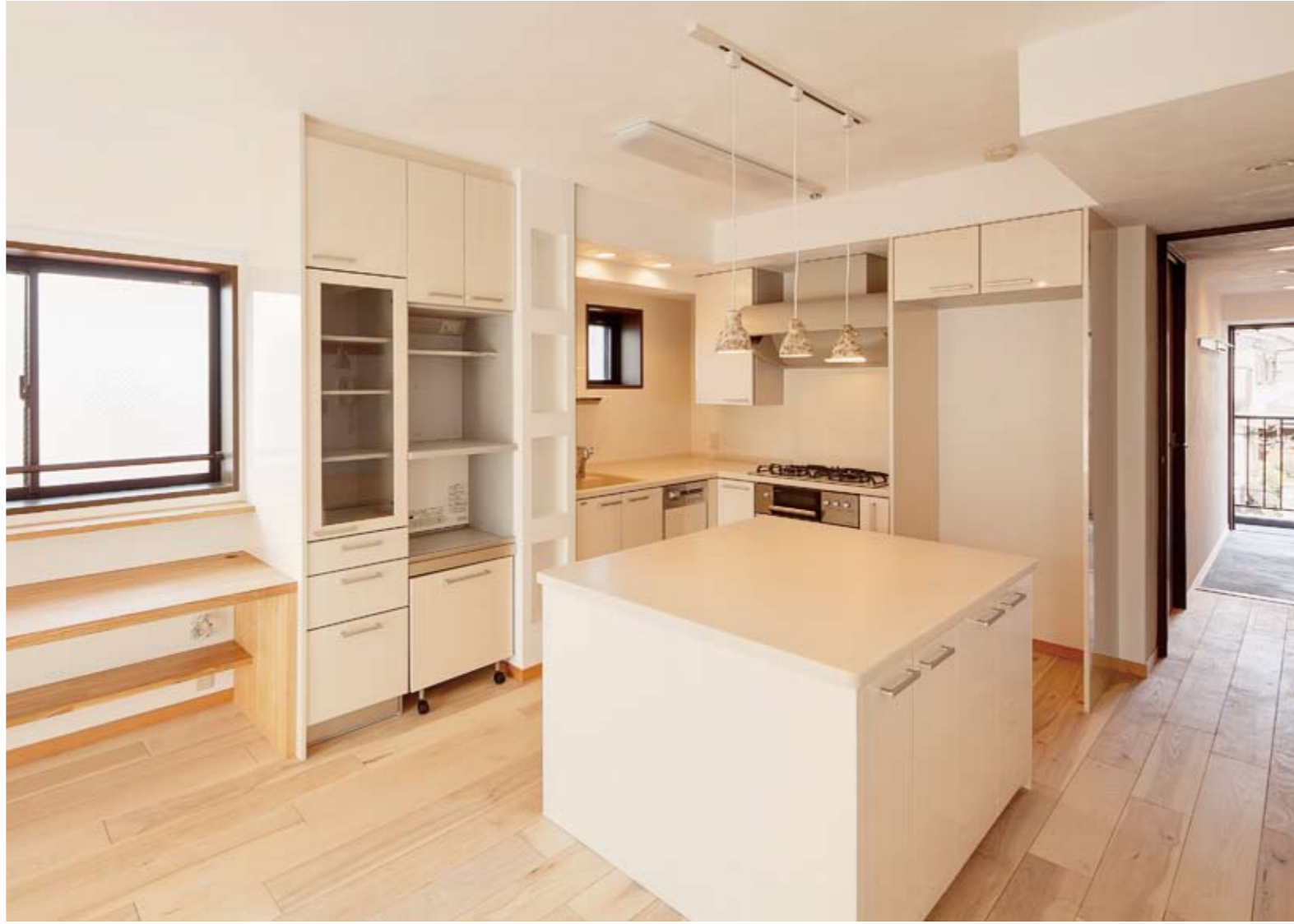
Mさんが気に入ったという使いやすいキッチン。L字型のキッチンとシステムストッカー、中央にあるアイランド型のカウンターは既存のものをついたん取り外し、内装工事後に再設置。キッチン横の4段のニッチは表面のみ漆喰で化粧。コストを抑えて自然素材の風合いをプラス
